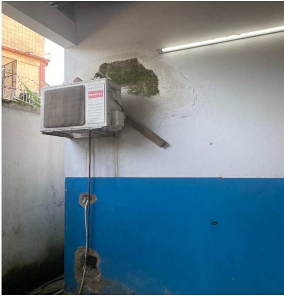
SYSTEME DE VACUATION DE PLOMBERIE REFECTION EXTERIEUR SUR MURS ET PEINTURE
